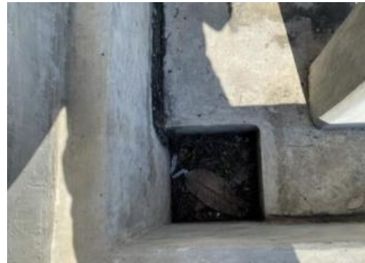
รูปที่ 3-13 รางระบายน้ำฝน บริเวณพื้นที่ที่อาจมีน้ำมันปนเปื้อน
