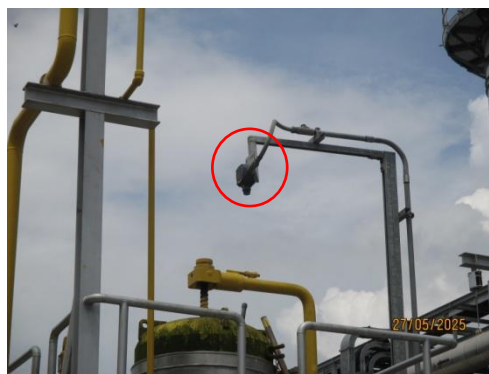
รูปที่ 3-46 เครื่องตรวจจับการรั่วไหลของก๊าซธรรมชาติ (Gas Detector)
